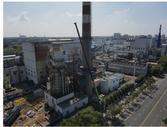
图4 事发当日烟道作业现场
