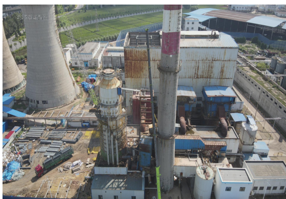
图5 事发当日吊装作业现场
